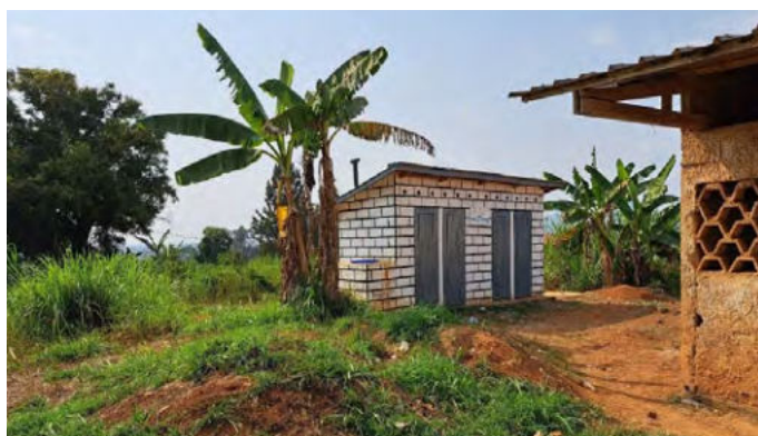
Mbankomo im Kamerun. Bau von vier Pilot-Ökotoiletten in zwei Schulen ©UNICEF
